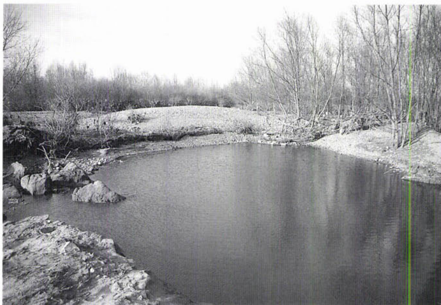
Doorbraak met kolk als gevolg van het hoogwater bij Negenoord, Stokkem. De dynamische krachten van de rivier zijn hier goed te zien.
